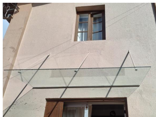
Foto 6 – Nova proteção no acesso à loja de calçados
