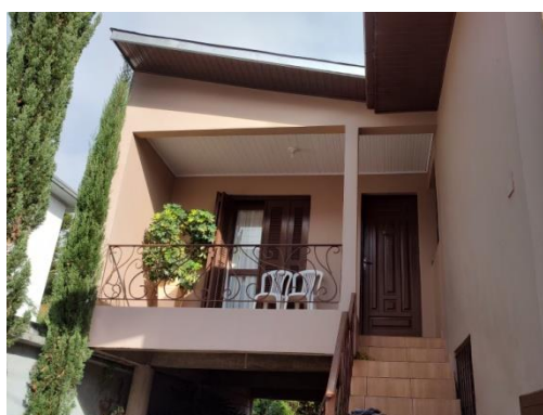
Foto 5 – Ampliação na face sul
